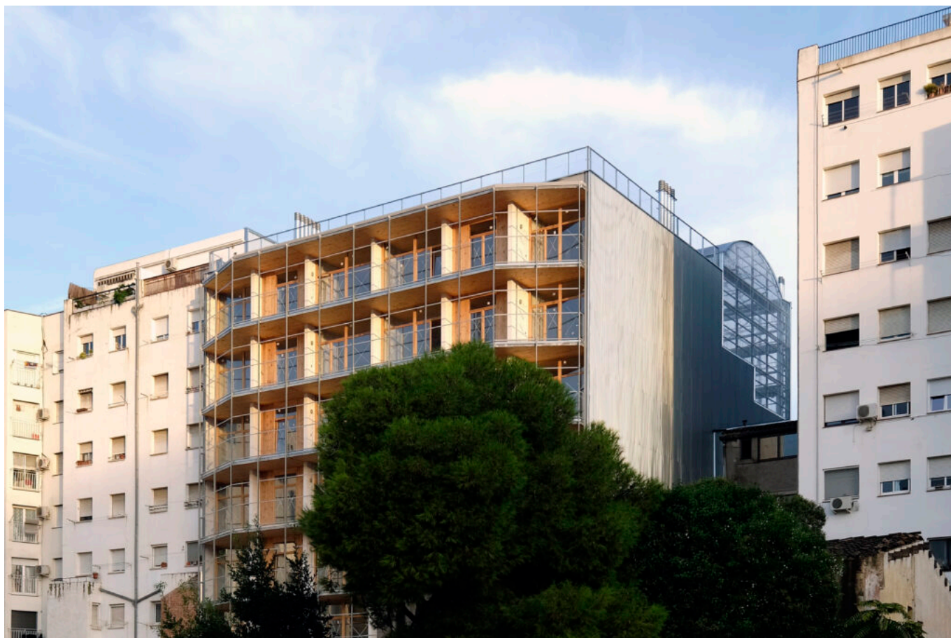
Façana de l'edifici La Borda, al barri de la Bordeta de Barcelona, on es pot veure perfectament l'ús intensiu de la fusta / LA BORDA
